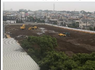
グラウンド拡張工事 進行中
