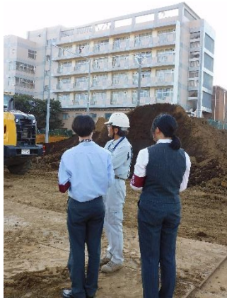
↑工事で掘られた土は現部室棟の横になだらかに積み上げられていた。新グラウンドはこれから30cmかさ上げされる予定だという。
