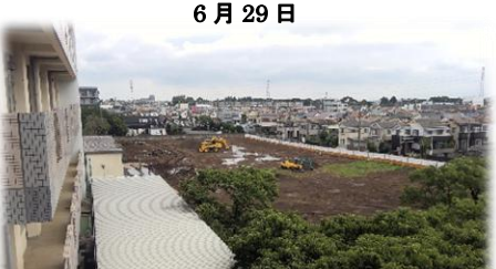
6月29日 工事が本格的に始まって土を掘っている
