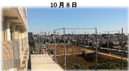
10月8日 2号棟4階から定点観測中！
