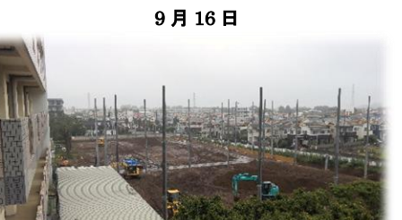
9月16日 照明器具などがつく支柱が立てられた
